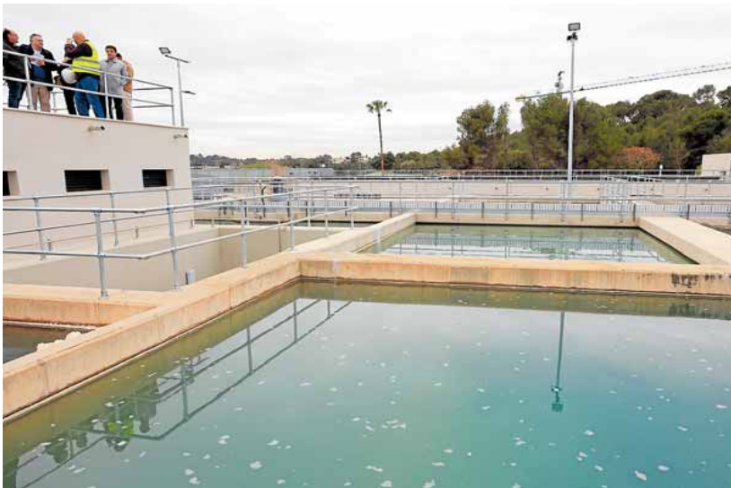
Obras en la planta potabilizadora de La Presa. AYTO VALENCIA
